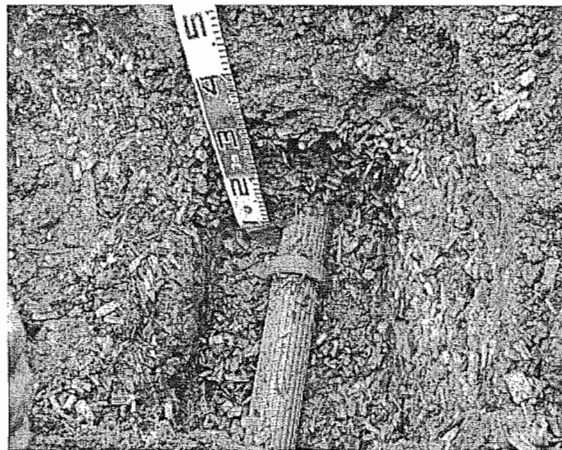
被覆材の劣化状況調査
